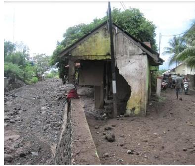
**Gambar 3** (c) Tumpukan material sedimentasi menutupi badan jalan (d) dinding rumah hancur dan sebagian besar badan jalan di tutupi material sedimen (sumber data Badan Vulkanologi dan Mitigasi Bencana Geologi, Pos Pengamatan Gunungapi Gamalama Ternate 2012)
