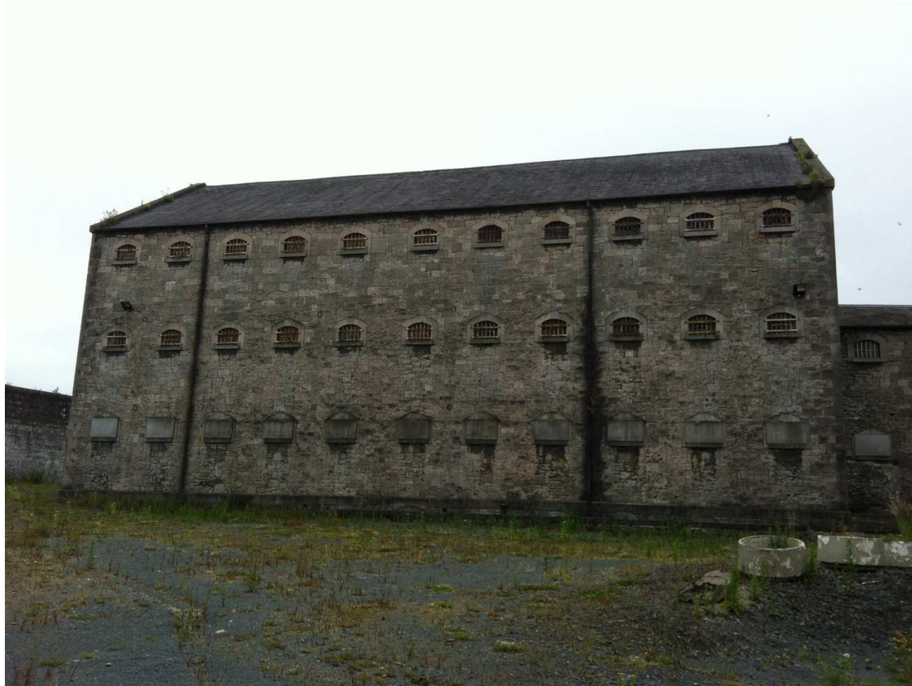
Ala "A", Presó d' Armagh - Es poden veure les finestres de la primera planta tapiades durant la no -
