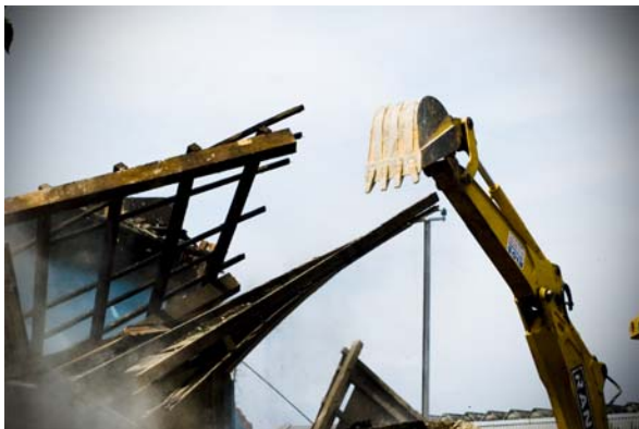
Foto 01: Cena do início da demolição.
