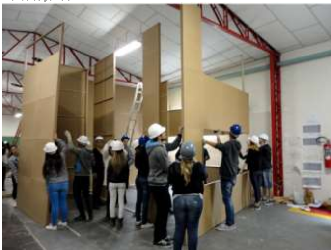
Figura 8. Sequência de imagens da montagem do mesmo mock-up . Manobrando e fixando os painéis.
