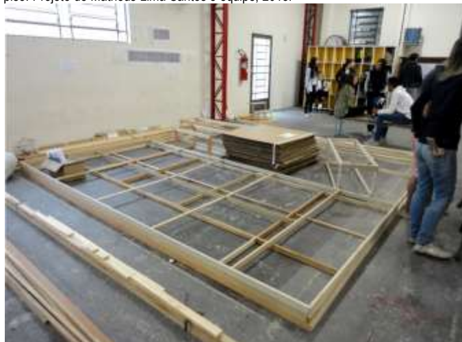
Figura 4. Painéis de madeira executados independentemente e empilhados sobre o piso. Projeto de Matheus Lima Santos e equipe, 2015.
