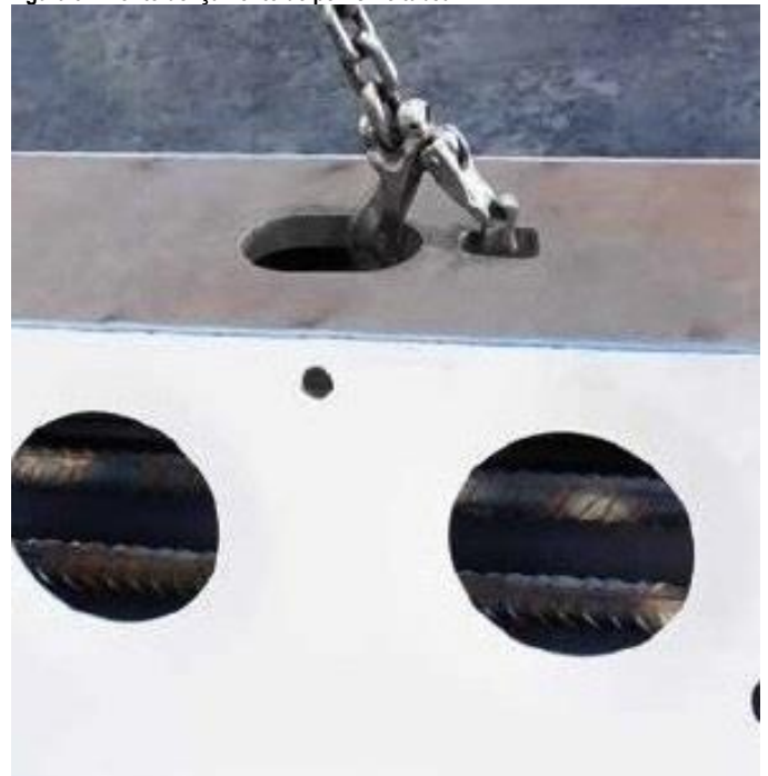
Figura 9 – Ponto de içamento de perfis Deltabeam®
