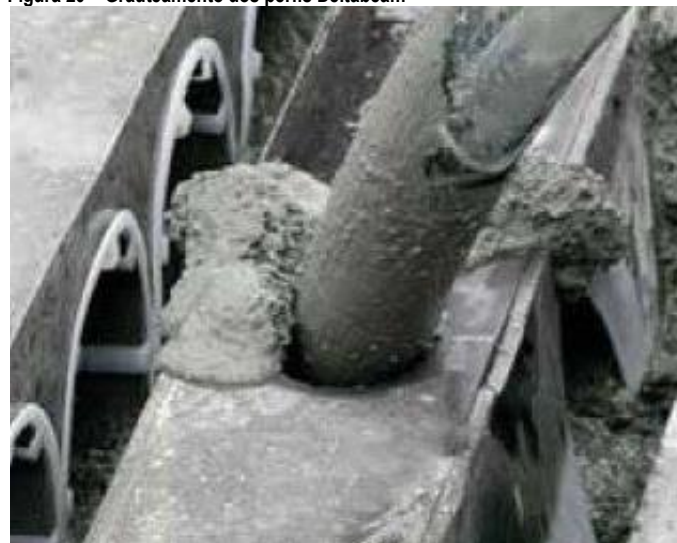
Figura 20 – Grauteamento dos perfis Deltabeam®
