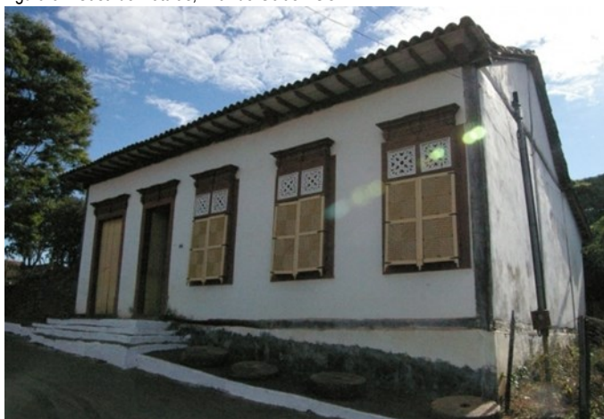
Figura 8 – Casa de Rótulas, Pilar de Goiás - GO
