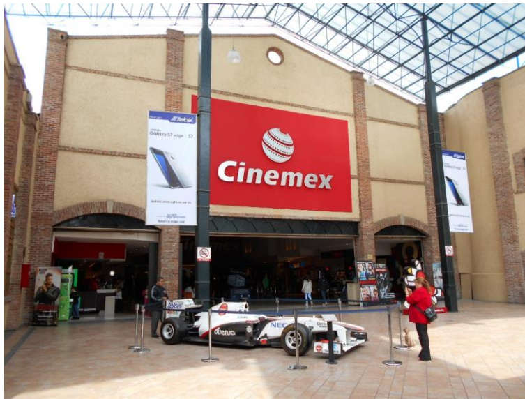
Figura 3. Estado actual de la antigua fábrica de Peña Pobre tras su reconversión como plaza comercial.
