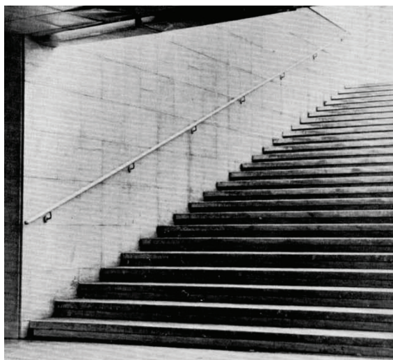
Сл. 4. Поглед на отворено једнокрако степениште из подземног пешачког пролаза, 1970.
