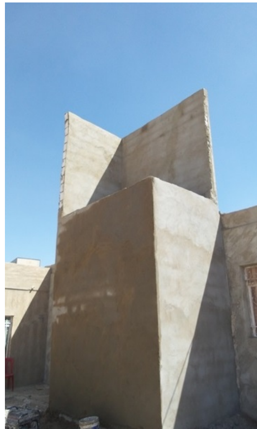
شكل(3): ملقف الهواء المنفذ/المصدر: [6]
