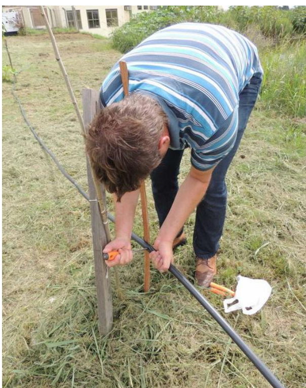
Figura 8. Sistema de irrigação sendo montado na área do arboreto, campus UNIPAMPA/São Gabriel. Dos autores.
