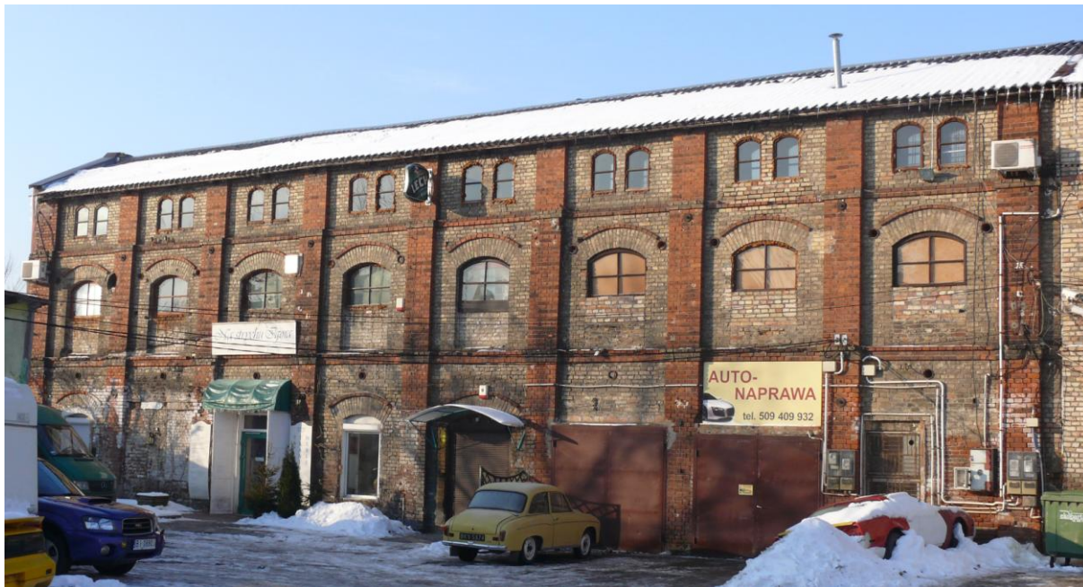
5. Budynek pofabryczny przy ul. Jurowieckiej 31, widoczny także na rycinie reklamowej z 1921 r. Fot. Wiesław Wróbel 2011.
