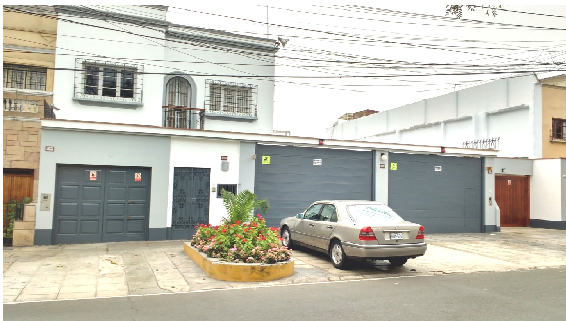
Foto 1: vista de la fachada de los tres terrenos. Fuente: propia
