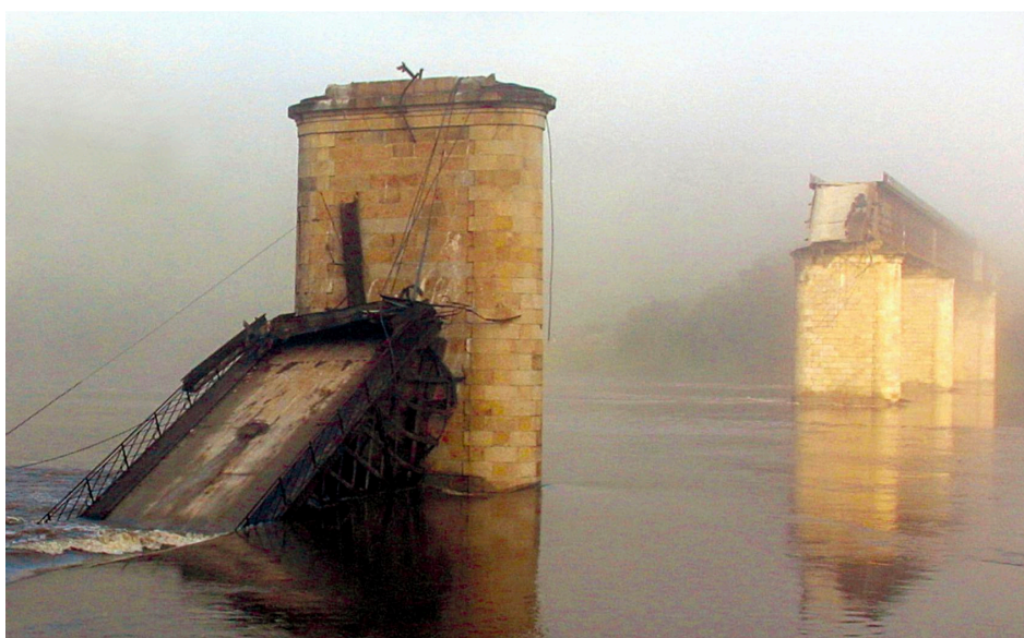
Figura 1.4 - Queda parcial do tabuleiro da Ponte Hintze Ribeiro em 2001.
