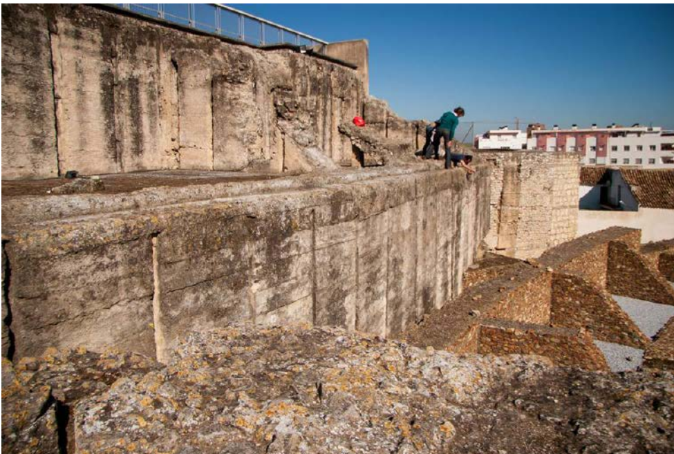
Figura 8. Fase de muestreo en campo en la estructura monumental sobre el cerro de San Antonio (foto: D. González Acuña, CAI).
