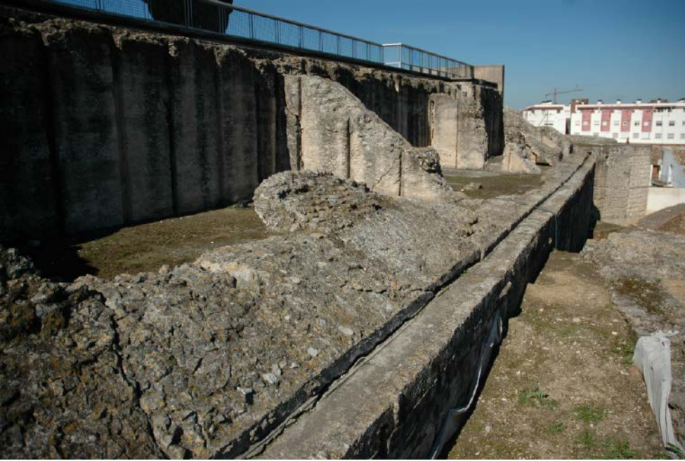
Figura 6. Detalle de las características morfológicas del conjunto, a base de potentes muros paralelos y riostras transversales.
