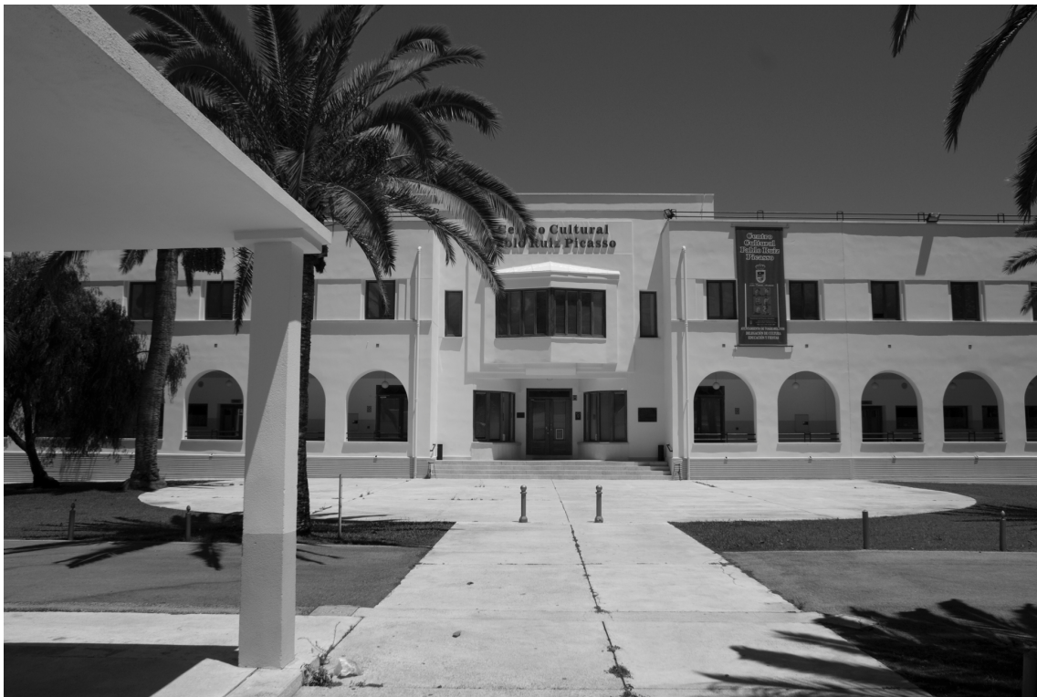
Fig. 6. Colegio de Huérfanos de Ferroviarios de Torremolinos. Detalle fachada principal Oeste con galerías de aulas, 2008. Autor: Jacques Maes.
