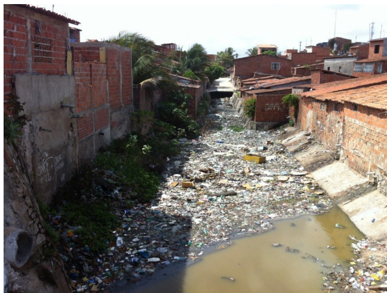
Figura 4: Galeria pluvial localizada próxima à Avenida Litorânea, Pirambu-CE
