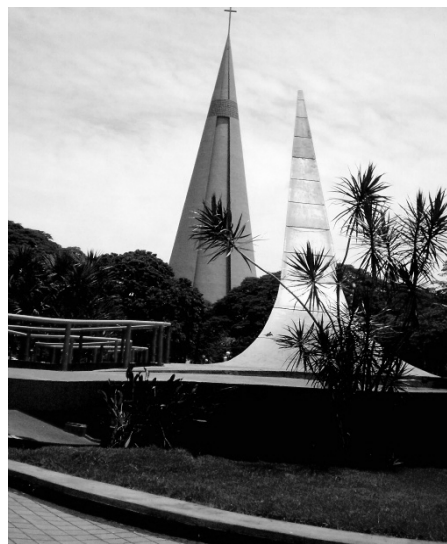
Imagem 1 – Obelisco e Torre da Catedral ao fundo – Vista do Centro de Convivência Comunitária Renato Celidônio. Foto: Sandra Pelegrini.
