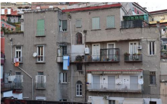
Figura 7: Edificio della tipologia case d'affitto pre-ottocentesche senza intonaco sulle facciate e con balconi posticci.
