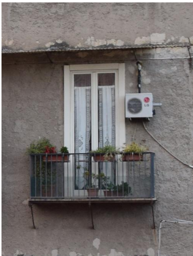
Figura 9: Balcone realizzato con lastra in marmo su supporto metallico
