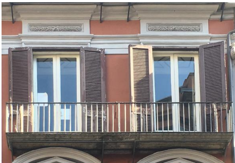
Figura 13: Balconi in piperno massiccio sorretti da una struttura metallica
