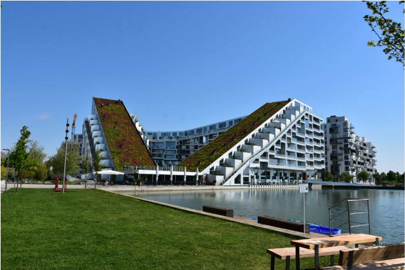
Figura 6: Tetto verde ad Ørestad, Copenhagen, Danimarca, 2018.
