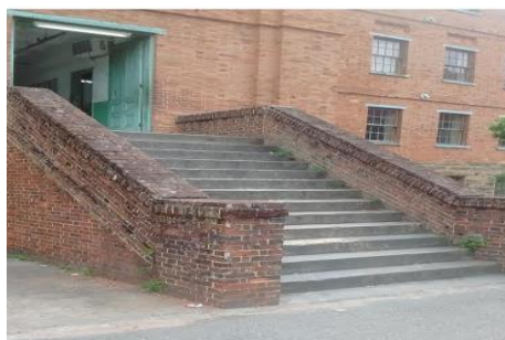
Fotografia 5 – Escada para acesso ao prédio
