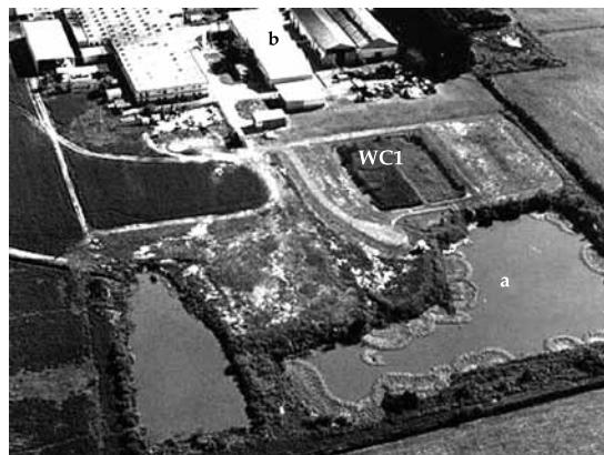
Figura 1. Fotografía de satélite donde se observa el humedal construido 1 (HC1), la laguna (a) e instalaciones de la empresa (b).
