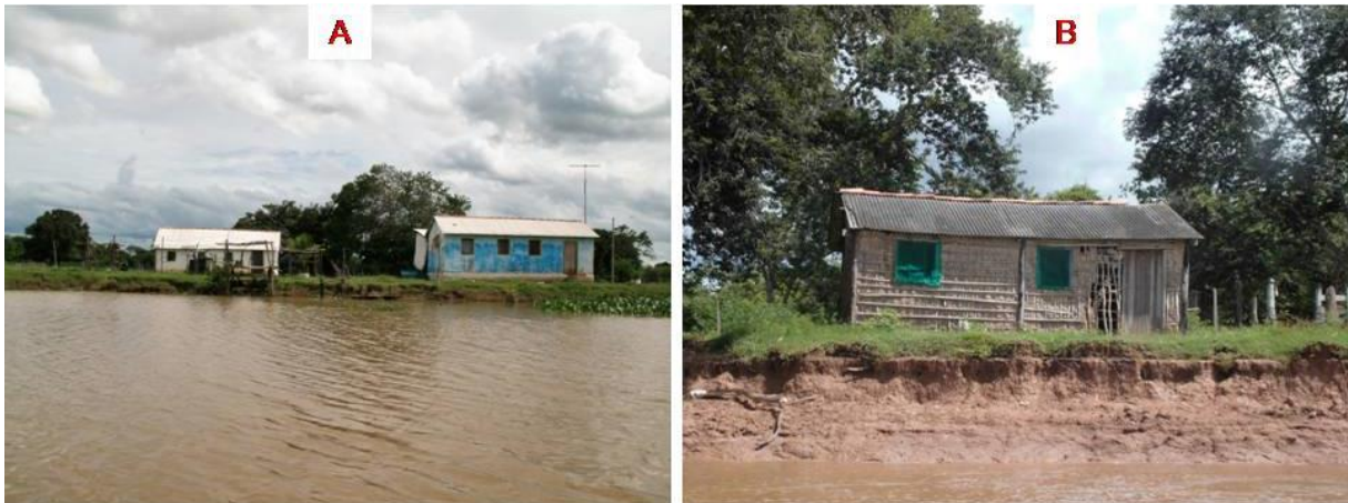
Figura 1 – Residências ribeirinhas na margem do Rio Cuiabá: A – Casa de Alvenaria; B – Casa de Pau a pique (madeira e barro), município Barão de Melgaço – MT.
