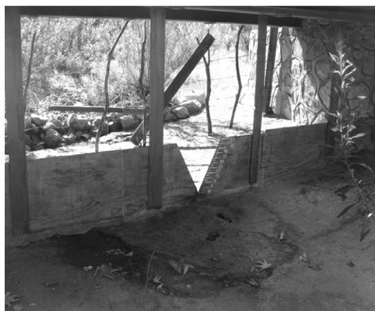
Figura 2. Vertedor triangular de pared delgada.
