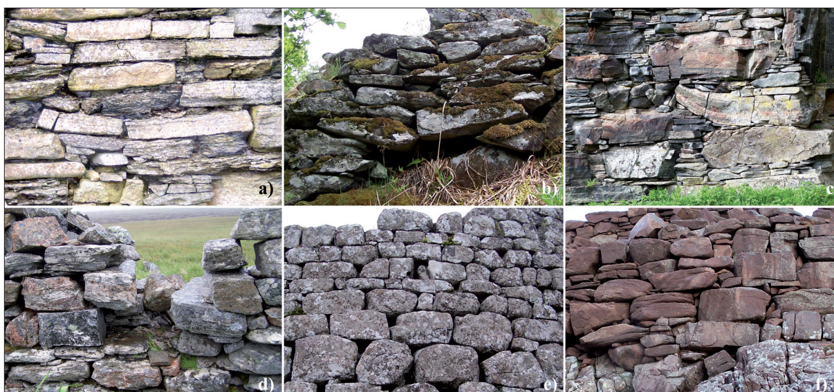
Abb. 9. Mauerwerksbilder verschiedener brochs: a) Sandstein, lagig in Steinplatten verbaut: Hillock of Burroughston, Orkney; b) schiefriiges Gestein: Druim An Duin, Argyll; c) Gneis, lagig in Steinplatten und Blöcken verbaut: Dun Troddan, Glenelg; d) Gneis, in Blöcken verbaut: Dun Borve, Western Isles; e) Basalt: Dun Hallin, Skye; f) Sandstein, in Blöcken verbaut: Clachtoll, Sutherland (Fotos: T. Romankiewicz).
