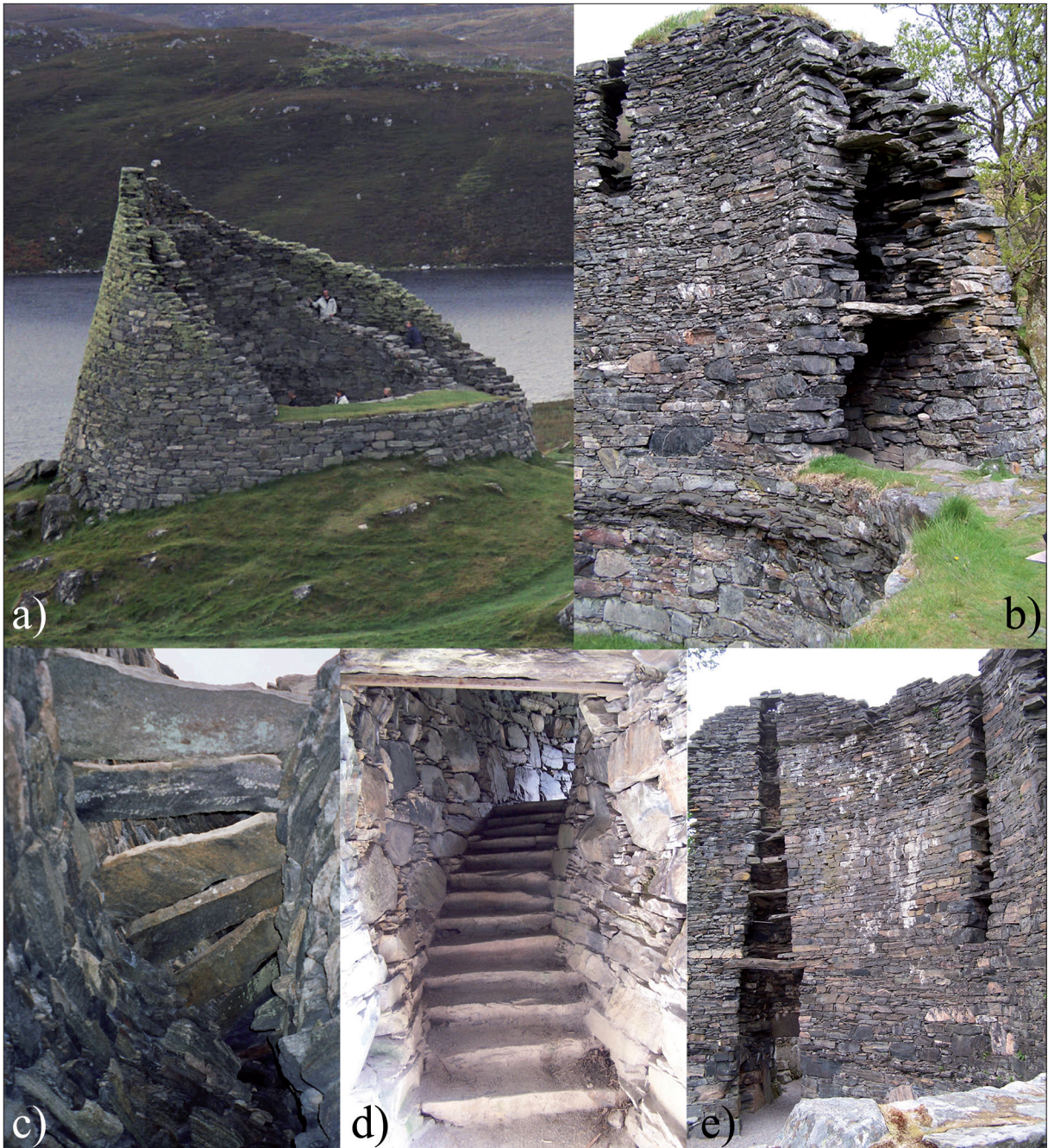
Abb. 3. Konstruktive Details der Brocharchitektur: a) und b) Doppelwandkonstruktion; c) Sturzsteine zwischen innerer und äußerer Wandscheibe; d) innenliegende Treppe zwischen innerer und äußerer Wandscheibe; e) vertikale Öffnungen in der Innenschale, die Innenraum und Mauerzwischenraum miteinander verbinden (Fotos: T. Romankiewicz).
