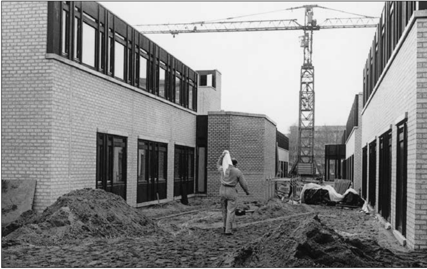
Thomas van Aquinostraat: de huisvesting van onder meer de Filosofische faculteit in aanbouw (1979).
