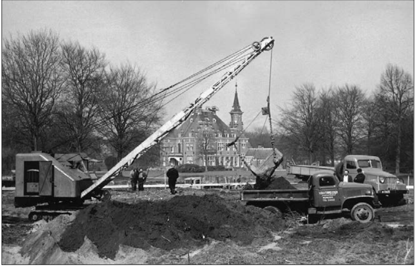
Werkzaamheden voor de medische faculteit in de 'achtertuin' van Huize Heyendael.
