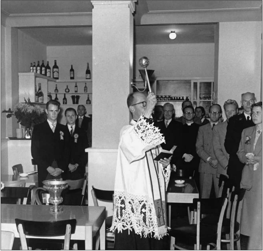
Inzegening van het Trefcentrum van het Nijmeegs Studenten Corps door moderator B.G.M. van Ogtrop SJ (1953).
