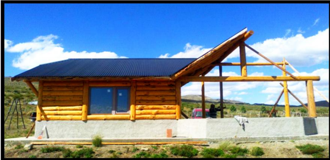
Figura 17 Vivienda unifamiliar de troncos: sistema constructivo de montaje en obra a partir de lectura de planos. Los troncos poseen tres caras planas y exterior rustico.
