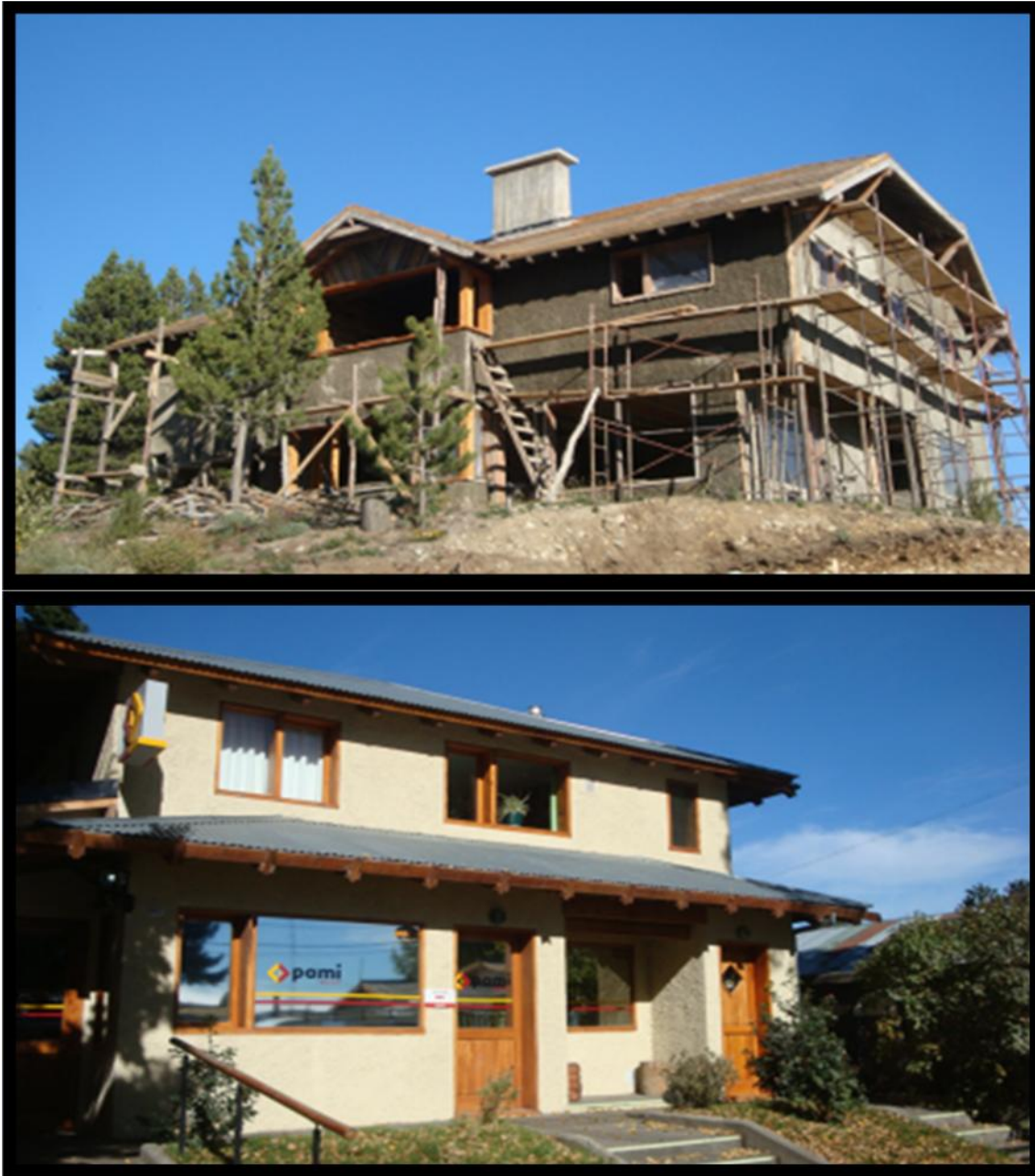
Figura 15 Viviendas hechas en San Carlos de Bariloche siguiendo el sistema constructivo de ballon-frame con uso de madera proveniente de raleos comerciales de pino ponderosa y otras especies de la región. Una vez realizado en revoque, la madera queda escondida, no visible a la vista, simulando una casa de mampostería.
