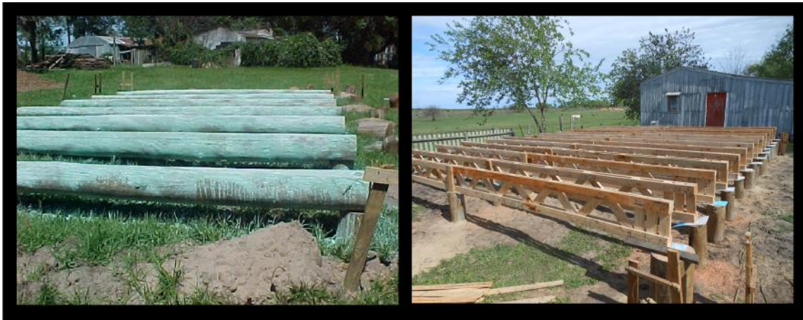
Figura 12 Sistemas constructivos presentados como casos exitosos para el NOA argentino a partir de madera de Eucaliptus Grandis (Fotos: gentileza de Martín Sánchez-Acosta)
