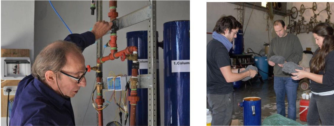
Figura 7.15. Montaje de la planta para el tratamiento de 4 m 3 /día en la cooperativa de Verónica.
