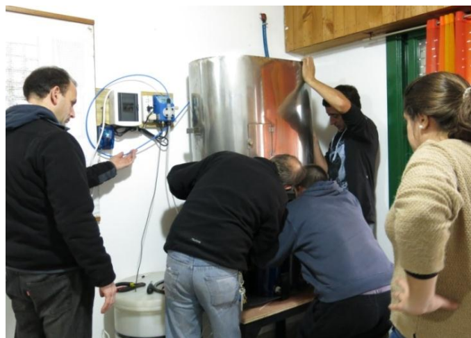
Figura 7.8. Instalación del prototipo en la localidad de Castelli.
