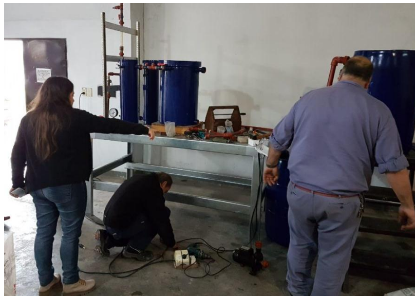
Figura 7.14. Montaje de la planta para el tratamiento de 4 m 3 /día en la cooperativa de
