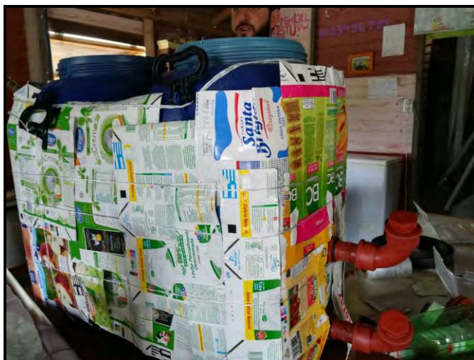
Figura 1.- Tanque de almacenamiento del calentador solar
