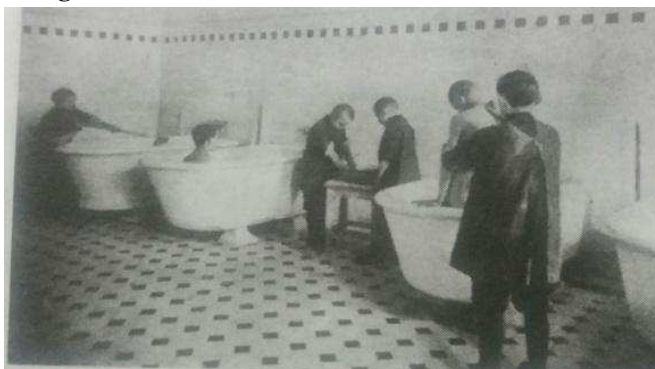
Imagem 14: Banheiro do Lar.
