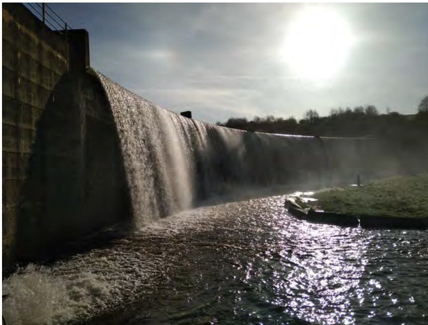
FIGURE 4.22: Barrage de Ribou en surverse
