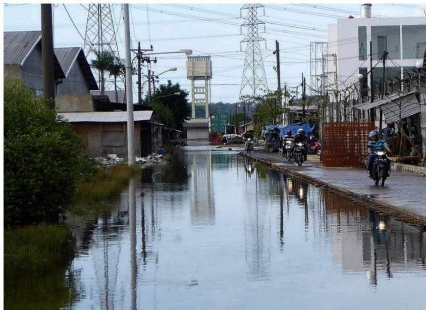
Abbildung 4-3: Überfluteter Industriepark und Straßenerhöhung in Semarang (Quelle: Javier Revilla Diez)
