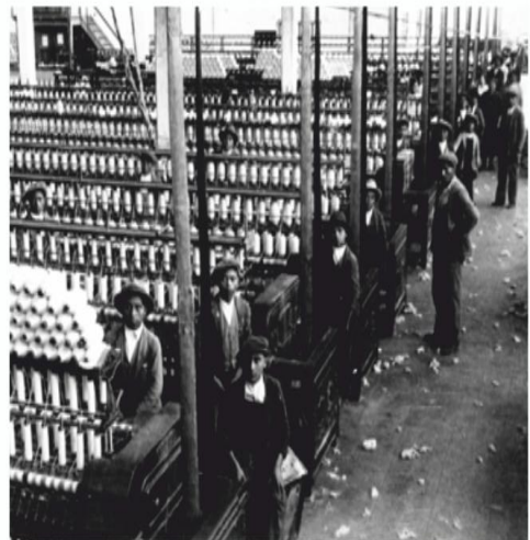
Imagen de la maquinaria textil de la Fábrica Textil Imbabura.
