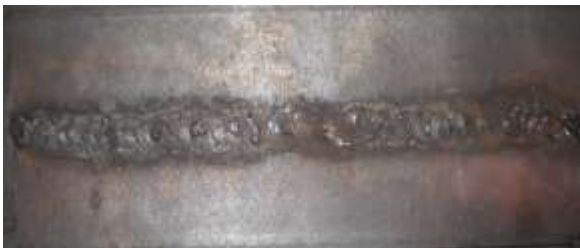
Figura 4.7. Cordón de soldadura horizontal SMAW.
