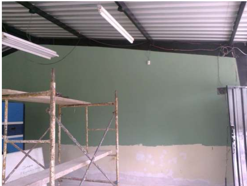
Pintada de paredes interiores.
