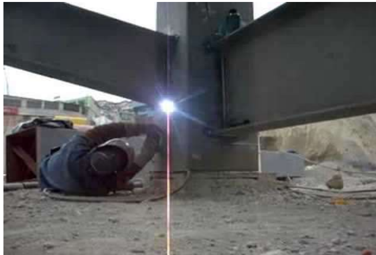
Figura 2.13. Soldadura sobre cabeza.
