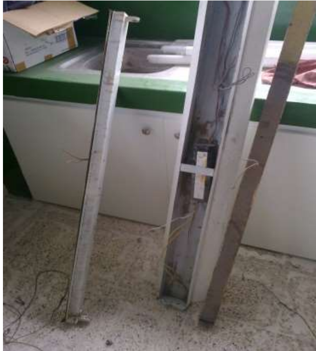
Instalación de lámparas.
