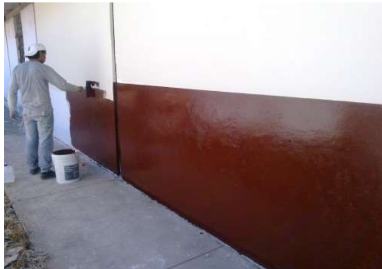
Pintada de paredes exteriores.
