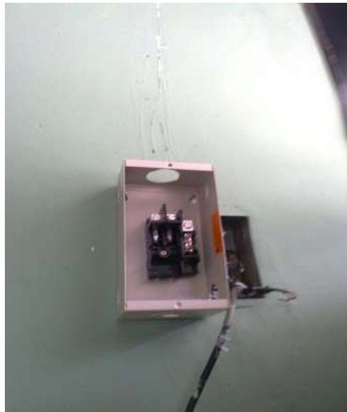
Instalación caja térmica.
