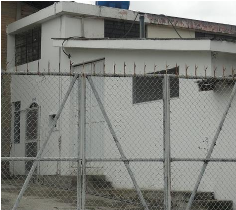
Ilustración 04: Instalación Área Administrativa – Financiera
