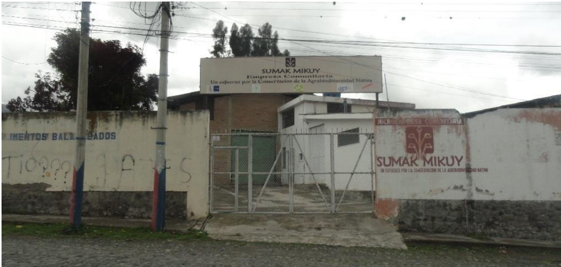
Ilustración 03: Instalación Frente Sumak Mikuy
