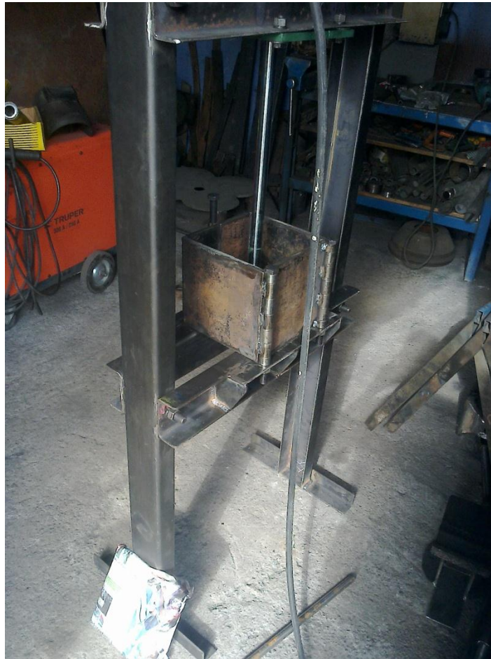
Figura 4.1 Ensamblaje molde estructura
