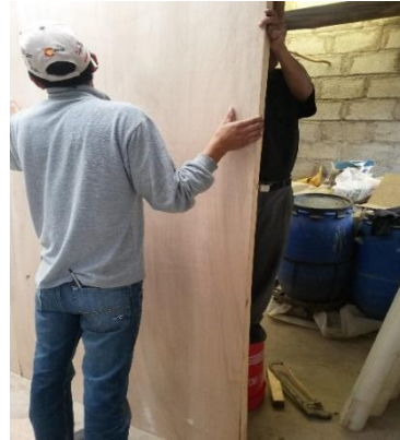
Fotografía 8. Colocación de tablero triplex
