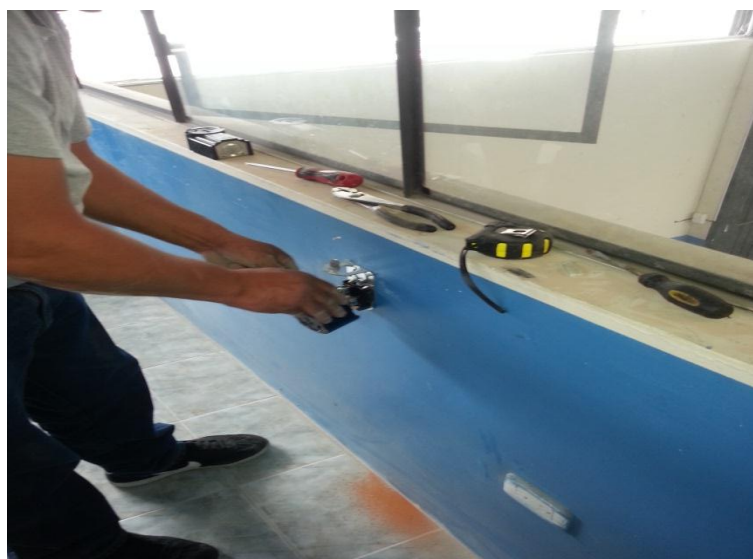
Figura 9: Instalación de tomacorrientes. Fuente. Foto tomada por el investigador (2015).
