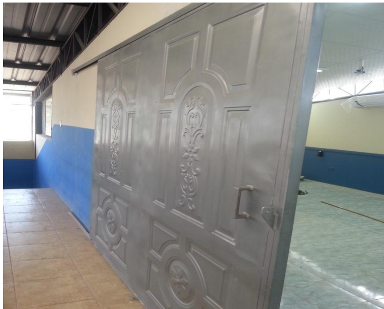
Figura 7: Puerta nueva colocada. Fuente. Foto tomada por el investigador (2015).
