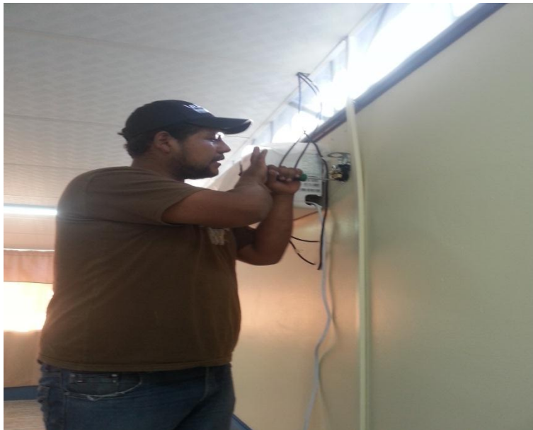
Figura 10: Instalando toma corrientes para los Aires acondicionados. Fuente. Foto tomada por el investigador (2015).
