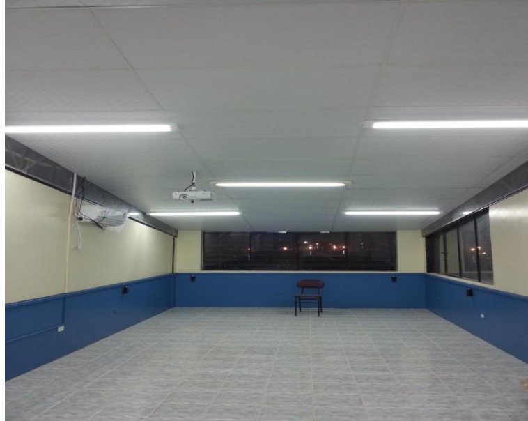
Figura 13: Laboratorio con adecuaciones terminadas. Fuente. Foto tomada por el investigador (2015).
