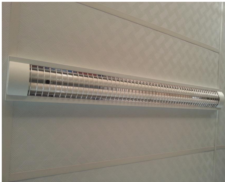
Figura 11: Lámparas nuevas colocadas. Fuente. Foto tomada por el investigador (2015).
