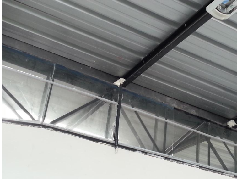
Figura 4: Impermeabilización de techo. Fuente. Foto tomada por el investigador (2015).
