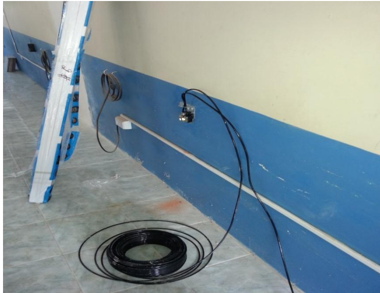
Figura 8: Instalación de cableado Fuente. Foto tomada por el investigador (2015).
