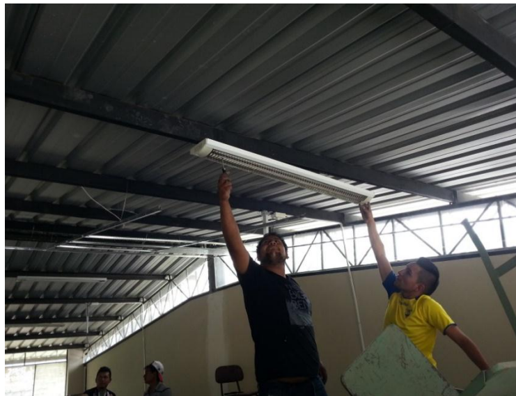
Figura 3: Extracción de lámparas antiguas. Fuente. Foto tomada por el investigador (2015).
