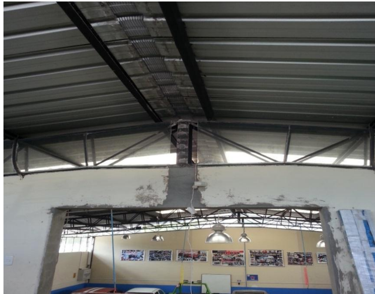
Figura 2: Ampliación de la puerta Fuente. Foto tomada por el investigador (2015).
