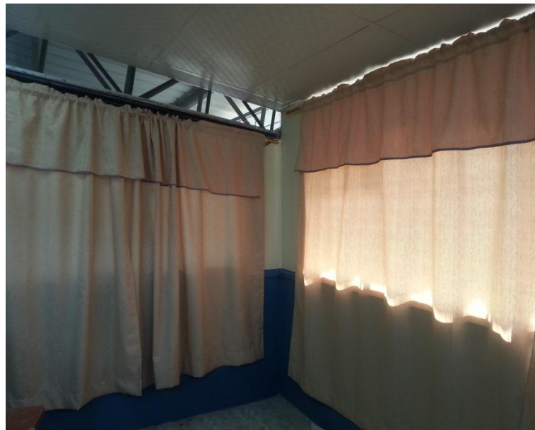
Figura 14: Cortinas colocadas. Fuente. Foto tomada por el investigador (2015).
