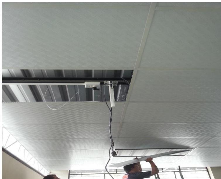
Figura 5: Extracción de lámparas antiguas. Fuente. Foto tomada por el investigador (2015).
