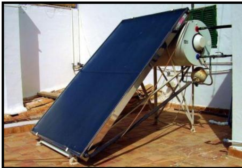
GRÁFICO No.3.19 Modelo de un sistema solar para calentar el agua.
