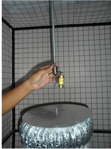
Figura 33. Aislamiento colocado en punta de prueba tipo péndulo
