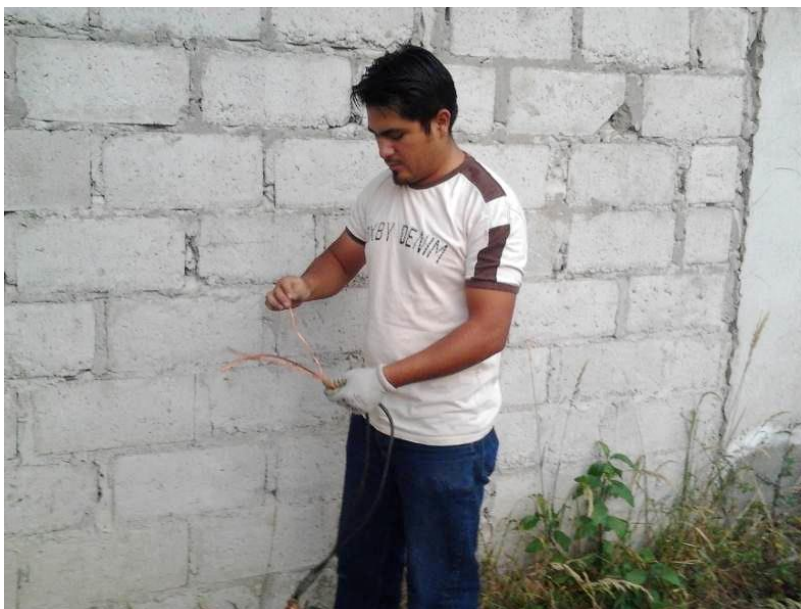
Figura 20. Preparación del conductor para la puesta a Tierra
