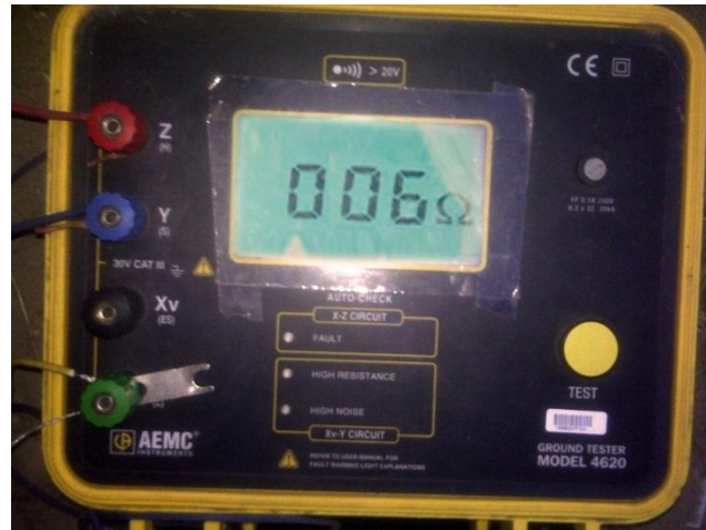
Figura 25: Medición de Resistividad de Tierra
