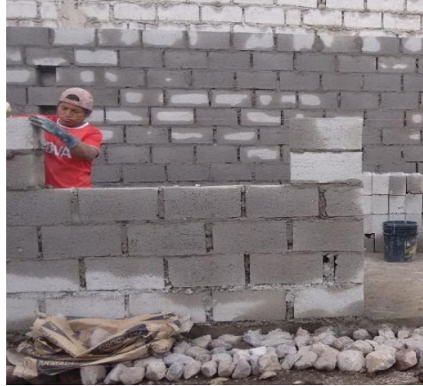
Foto 2. Construcción del galpón
