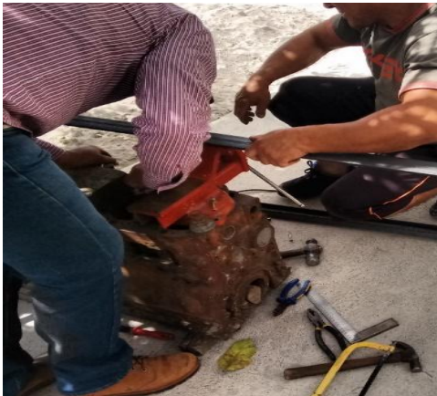
Foto 3. Elaboración de las jaulas metálicas
