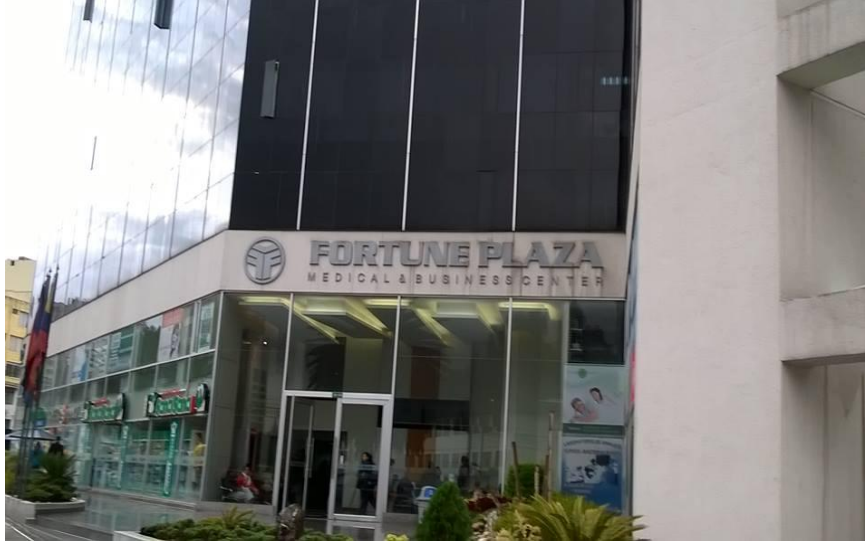
Edificio del centro Médico Fortune Plaza donde se encuentra Hiperbárica S.A
