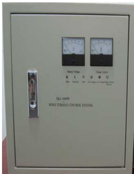
Gráfico N° 42 Controlador híbrido de carga
