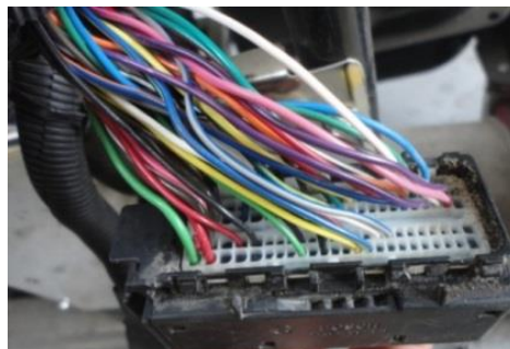
Figura 3. Cables de la ECU
