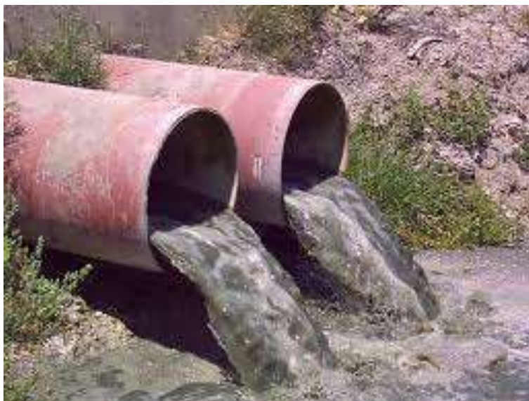
FIGURA 26: Efluente de descarga
