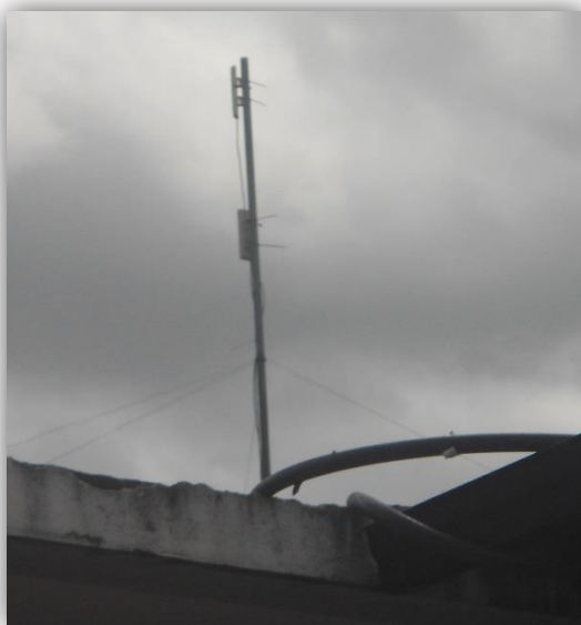
Figura 52: Actuales instalaciones Municipio de Cotacachi
