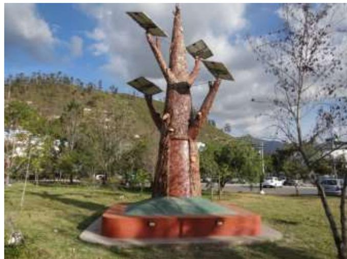
**Figura N° 34** Árbol solar con 4 paneles fotovoltaicos, sujetos a una rótula que permite giros de orientación.
