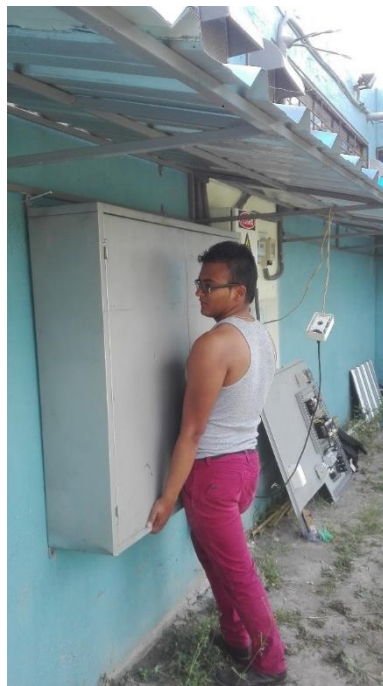
Figura 81: Montaje de tablero en la parte posterior de CIELE Fuente: Autor
