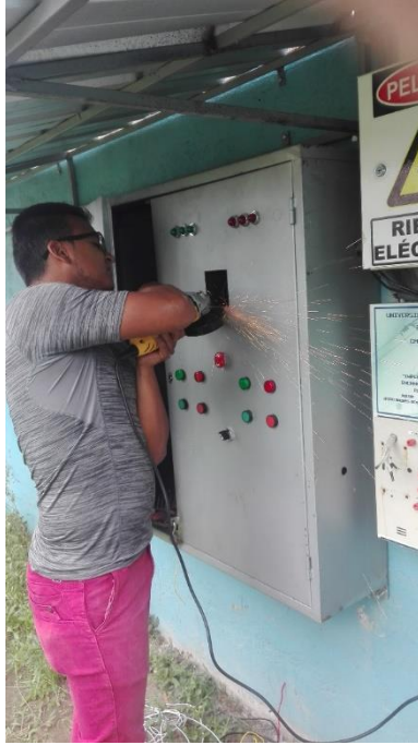
Figura 84: Realización de agujero para analizador de redes Fuente: Autor
