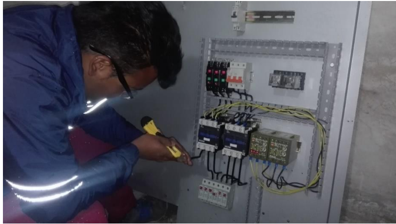
Figura 80: Instalado de circuito de fuerza Fuente: Autor
