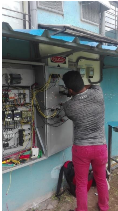
Figura 83: Instalación de elementos externos del TTA Fuente: Autor
