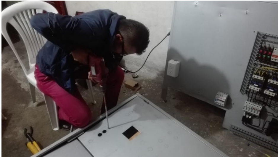
Figura 76: Perforaciones de guía para sacabocados
