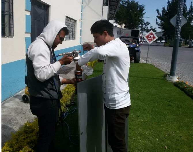
Figura 75: Pintado de tablero
