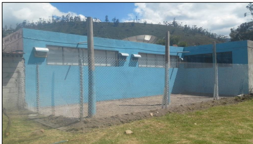
Figura 52: Instalación de malla de seguridad
