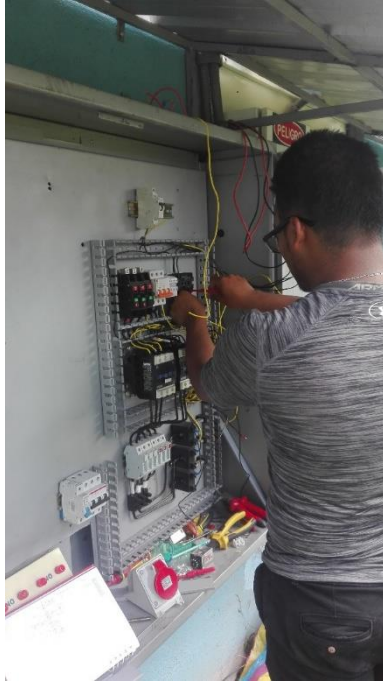
Figura 82: Instalación de elementos internos del TTA Fuente: Autor
