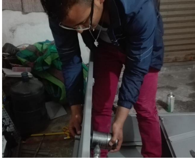
Figura 51: Perforación con sacabocado
