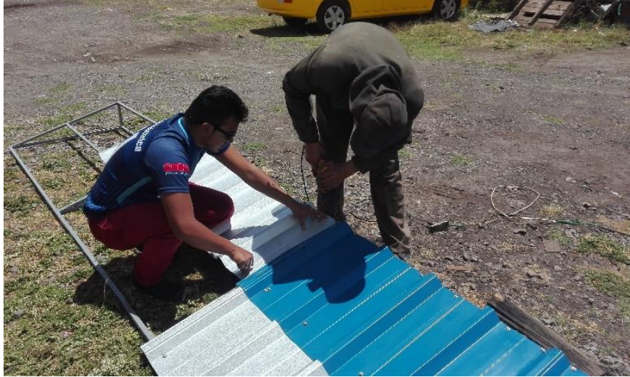
Figura 53: Armado de cubierta metálica
