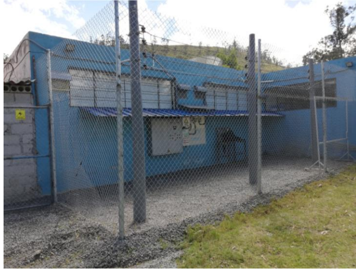
Figura 90: Readecuación patio de prácticas
