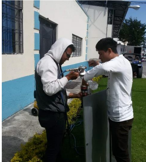
Figura 47: Mantenimiento del tablero
