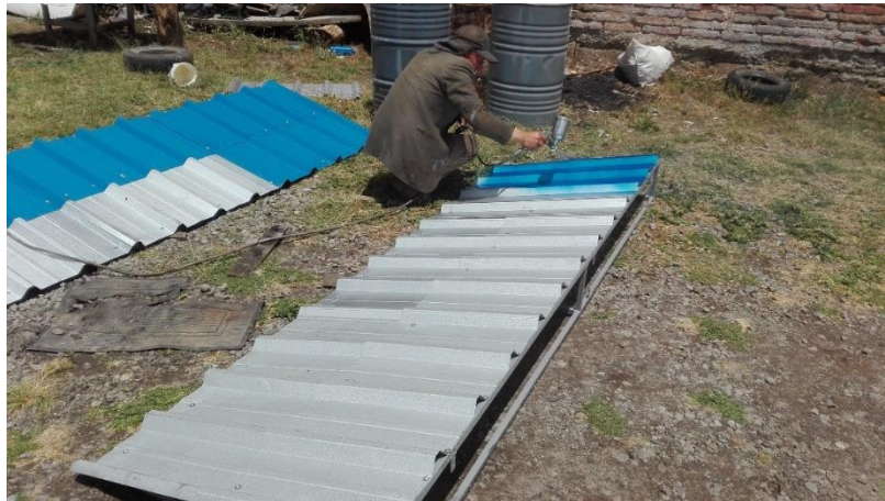
Figura 78: Pintado de techo Fuente: Autor
