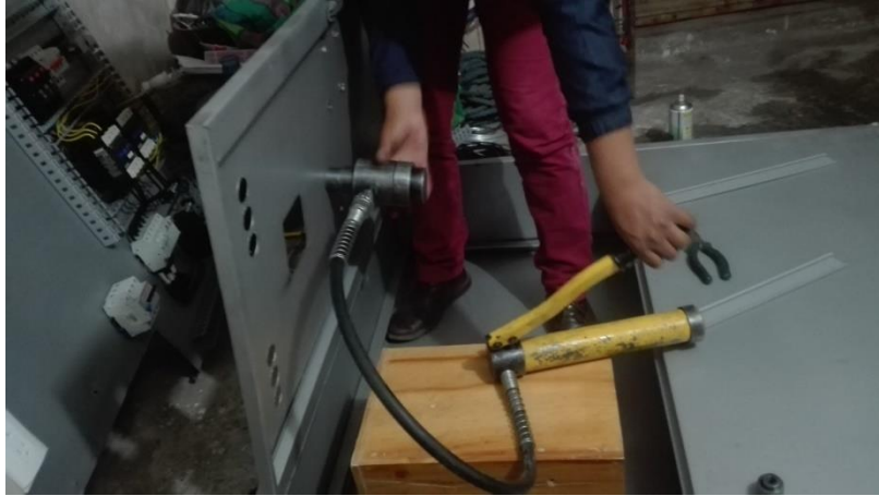
Figura 77: Utilización de sacabocado para perforación en latas Fuente: Autor
