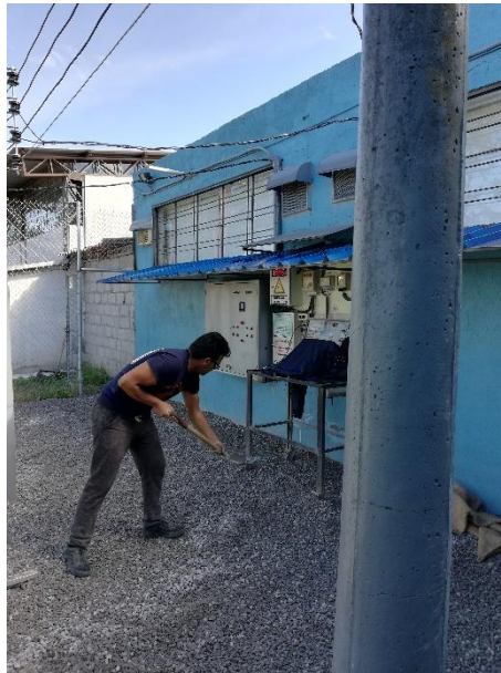
Figura 55: Readecuación de piso
