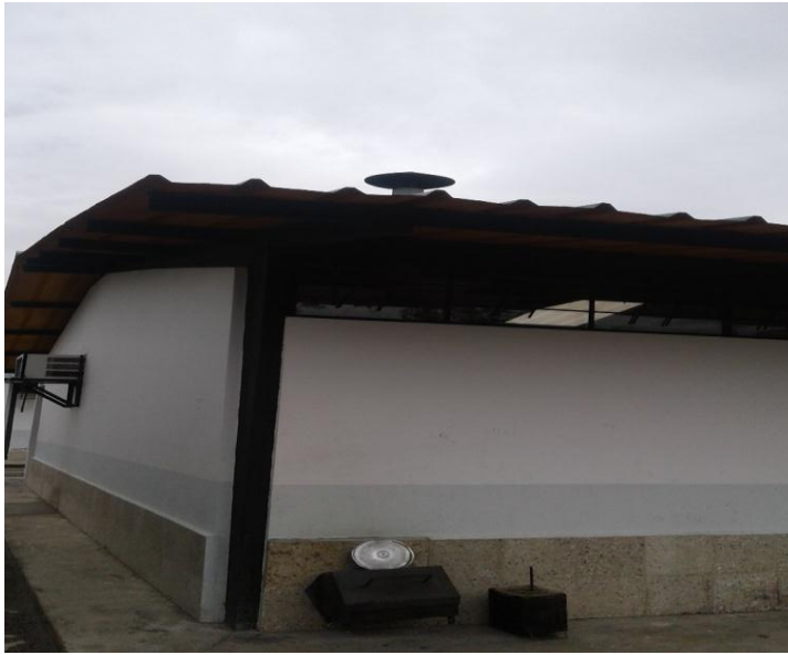
Figura 7: Instalaciones donde se encuentra ubicado la Unidad Edu-productiva.
