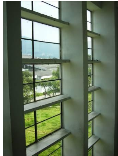
Abb. 255 Fenster des Treppenhauses. Foto Jan. 2007
