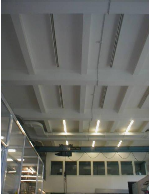
Abb. 111-112 Stahlbetonplatte der Maschinenhalle und Stahlbetonstruktur des Dachgeschosses.
