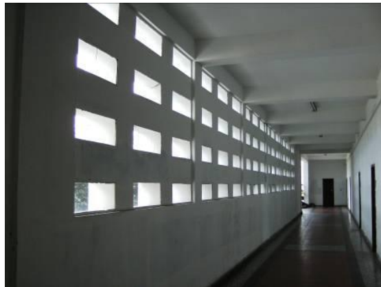
Abb. 252 Verschattung des Ganges durch die durchbrochenen Mauern. Foto Jan. 2007
