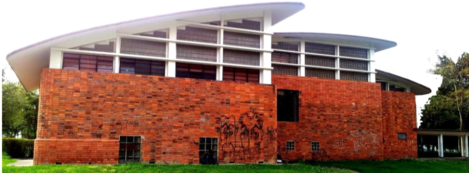
Abb.6 Seitenansicht der Druckerei der Universitätsstadt in Bogota. Das Gebäude wurde von Leopold Rother entworfen und zwischen 1947 und 1948 gebaut. Die Stahlbetonschalen der Überdachung sind nur 8 cm dick.
