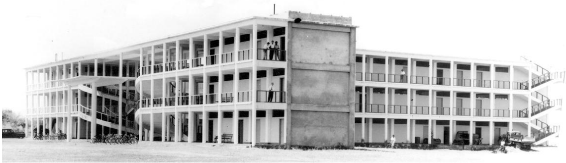
Abb. 315 Bildaufnahme des Hauptgebäudes während der Bauphase.
