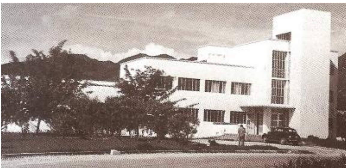
Abb. 265 Laborgebäude für Materialprüfung, Leopold Rother, 1940.
