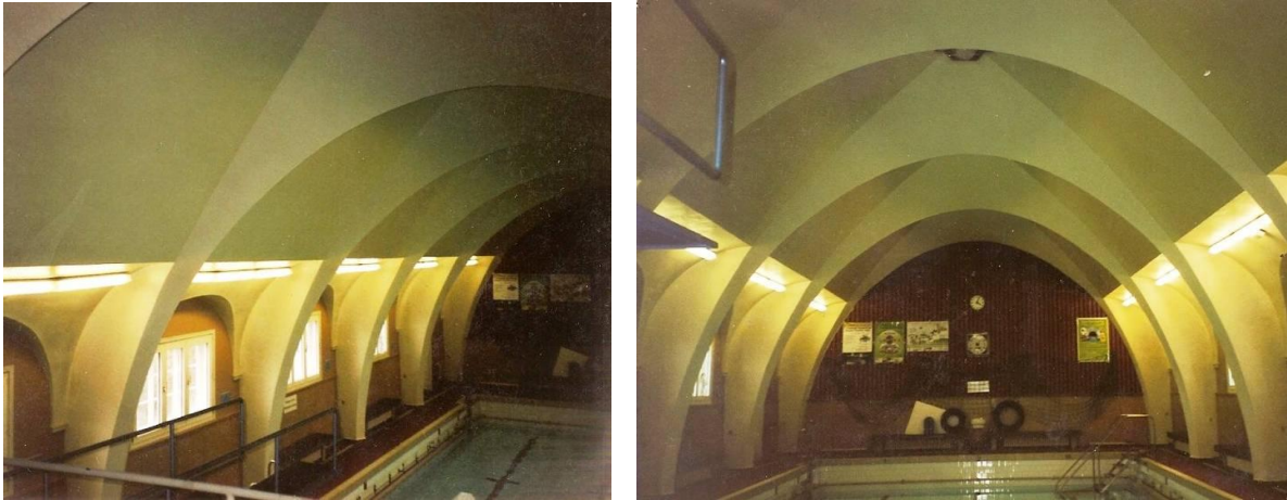
Abb. 90-91 Gipsgewölbe im Inneren der Schwimmhalle. Foto April 2004
