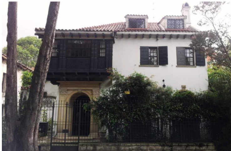
Abb. 285 Der Balkon beherrscht die neokoloniale Gestaltung des Hauses. Foto Jan. 2007
