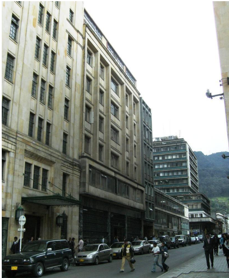
Abb. 288 Ansicht des Bürogebäudes. Foto Jan. 2007
