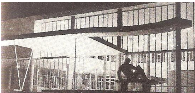
Abb. 27 Links: Oscar Niemeyer. Casino in Pampulha, 1942. Markise mit dünnen Metallstützen in V Form am Eingang des Gebäudes. Abb. 28 Rechts: Rother's Markthalle in Girardot
