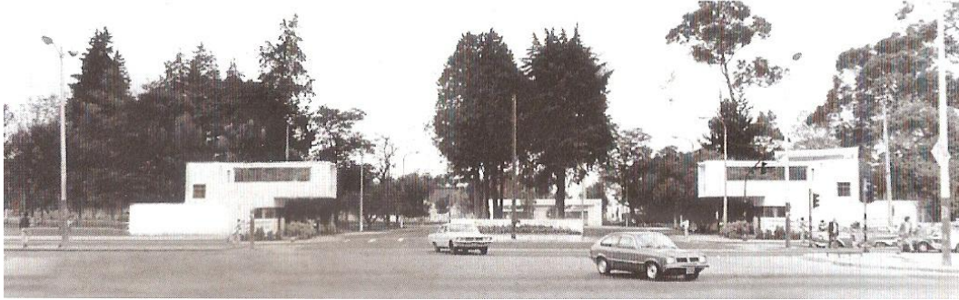
Abb. 245 Torgebäude der 45. Straße in den 70er Jahren.
