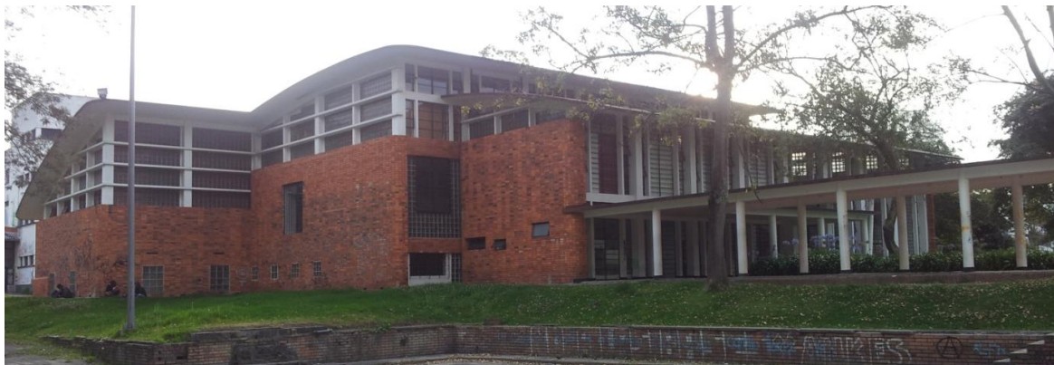
Abb. 333 West Ansicht. Foto Jan. 2008
