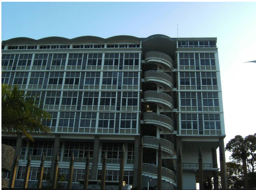
Abb. 352 Nord-Ansicht mit Wendeltreppe. Foto Jan. 2008
