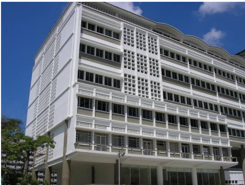
Abb. 363 Ansicht der West- und Nordfassaden. Foto Okt. 2004
