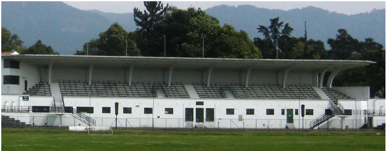
Abb. 223 Ansicht der Osttribüne des Fußballstadions in der Universitätsstadt. Die gekrümmten Stützen und die abgerundeten Ecken der Überdachung geben der Tribüne einen expressionistischen Ausdruck. Foto Jan. 2007
