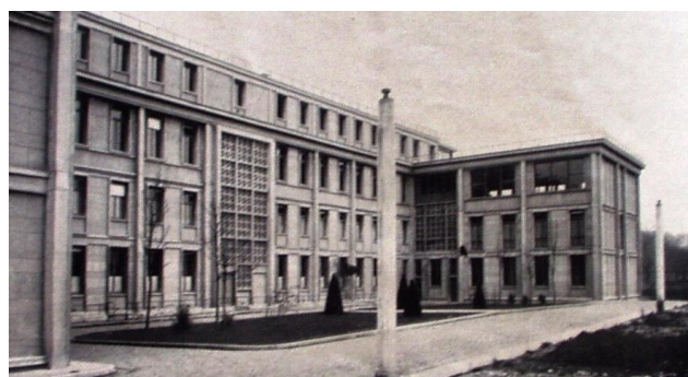
Abb. 269 Links: Die vorgefertigten Betonelemente, die Rother für das Nationale Chemische Institut verwendete, befinden sich in Perrets Entwürfen, wie z.B. in dem für das Marineministerium.
