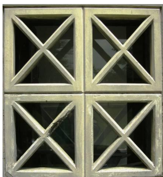
Abb. 269 Links: Die vorgefertigten Betonelemente, die Rother für das Nationale Chemische Institut verwendete, befinden sich in Perrets Entwürfen, wie z.B. in dem für das Marineministerium.
