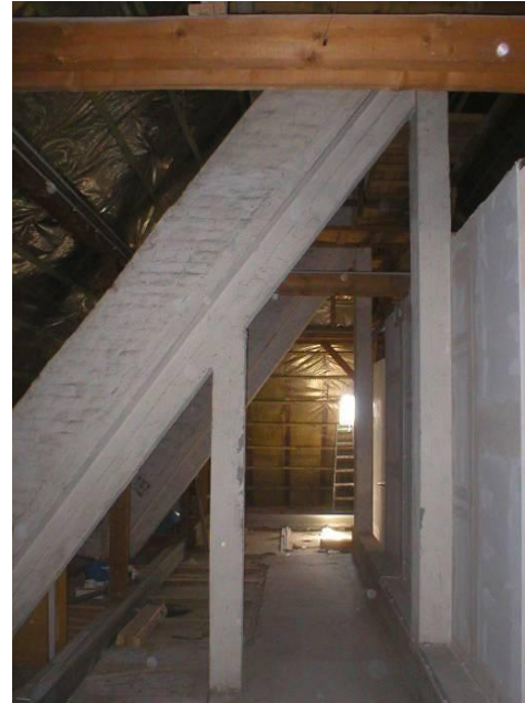
Abb. 111-112 Stahlbetonplatte der Maschinenhalle und Stahlbetonstruktur des Dachgeschosses.
