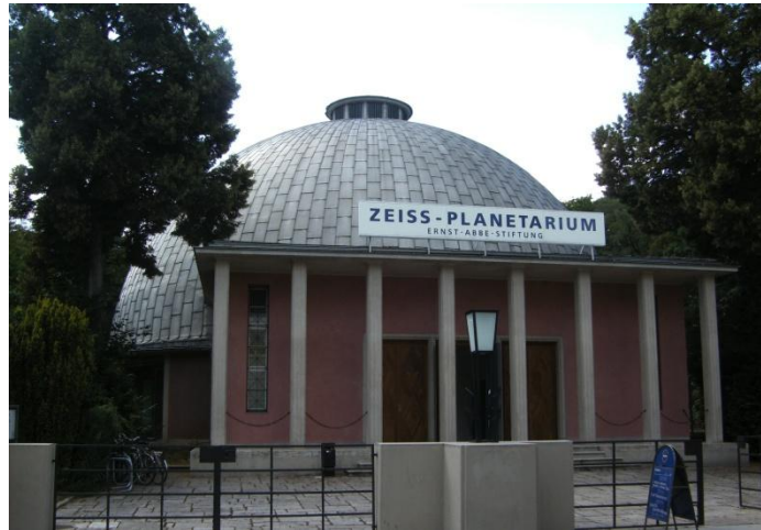
Abb. 384 Planetarium in Jena von Bauersfeld, Dyckerhoff & Widmann, 1924-1925. Die Schalenkuppel überspannte 25 m und hatte eine Stärke von nur sechs Zentimetern. Foto Juni 2010
