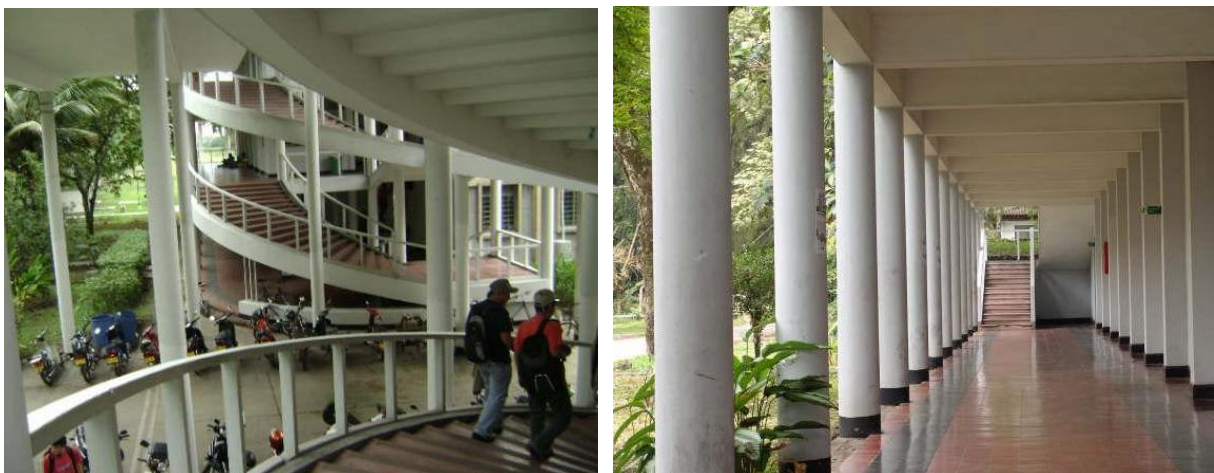
Abb. 316 Links: Die Wendeltreppen des Hauptgebäudes. Abb. 317 Rechts: Tragende Betonstützen des offenen Ganges im Erdgeschoss. Foto Jan. 2008
