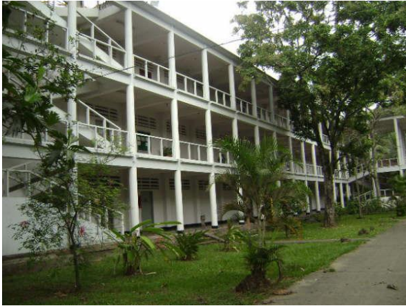
Abb. 318 Links: Offene Gänge mit tragenden Betonstützen der Unterrichtsblöcke. Abb. 319 Rechts: Blick vom Innenhof. Foto Jan. 2008
