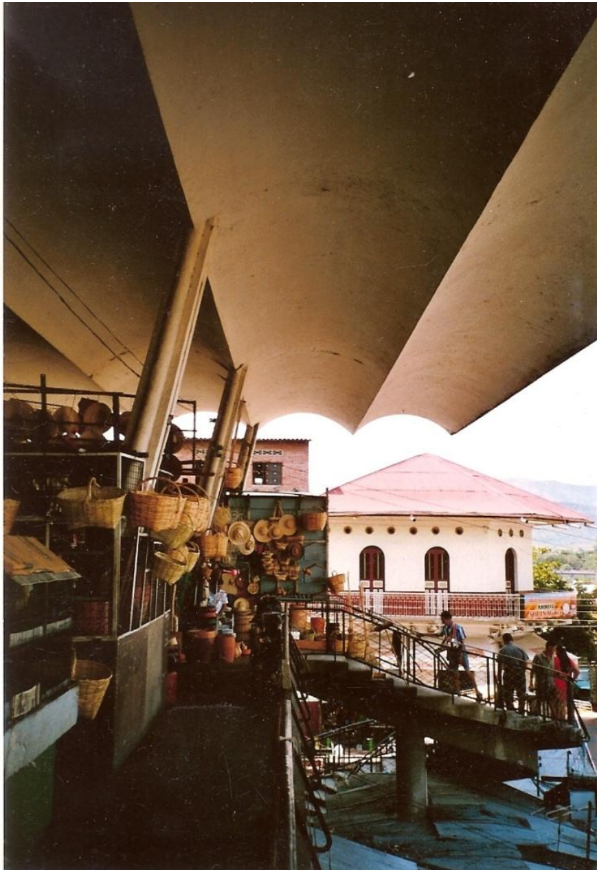
Abb. 364 Überdachung der Markthalle in Girardot. Die Betonschalen sind nur 5cm dick. Foto Jan. 2008
