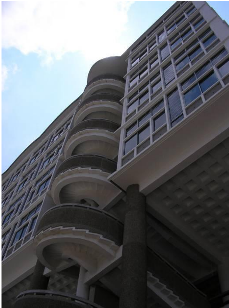
Abb. 362 Wendeltreppe der Nordfassade. Foto Sept. 2004
