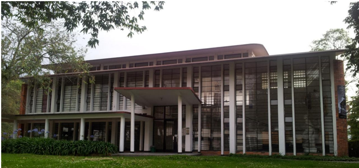
Abb. 323 Hauptfassade der ehemaligen Druckerei, heute Architekturmuseum Leopoldo Rother. Foto Jan. 2008
