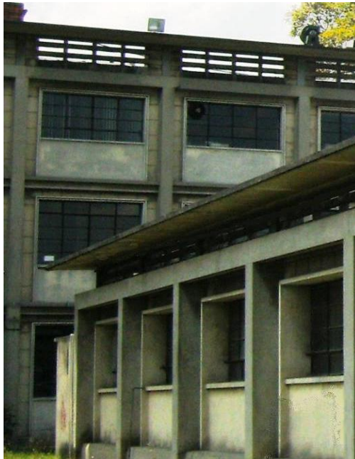
Abb. 271 In den Fassaden werden vorgefertigte Betonelemente benutzt, um Lichteffekte und Rhythmen zu schaffen. Die Attiken, Dachtraufen und Rahmen ergänzen die Struktur des Gebäudes. Foto Jan. 2007
