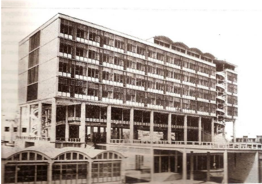
Abb. 344 Fotoaufnahme des National Gebäudes in den 50er Jahren des XX. Jahrhunderts.
