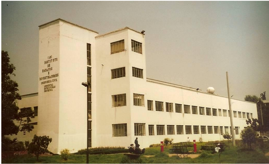
Abb. 258 Ansicht des Laborgebäudes für Materialprüfung. Im turmartigen Eckbau liegt das Treppenhaus. Foto Jan. 2007
