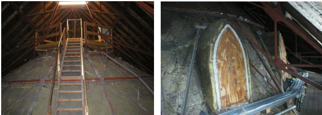
Abb. 76-77 Die Kuppeln der Aula bestehen aus Gipsdecken, die von Metallstrukturen gestützt werden.
