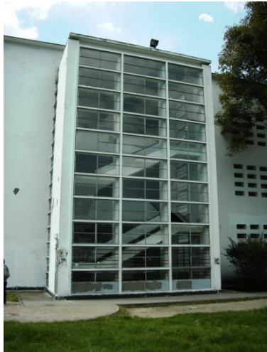
Abb. 254 Treppenhaus Foto Jan. 2007
