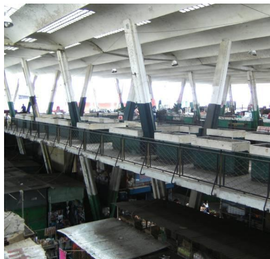
Abb. 370- 373 Die V-Stützen tragen das Obergeschoss und die Schalenüberdachungen. Foto Jan. 2008
