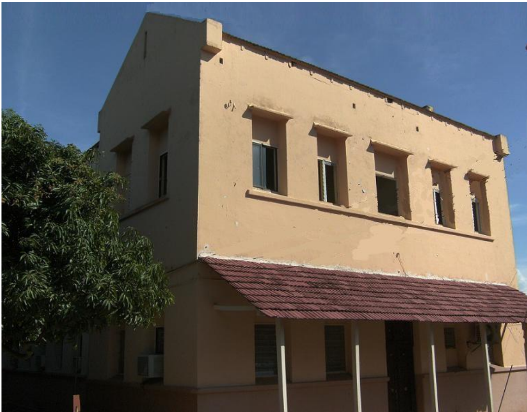
Abb. 157 Ansicht des Hauptgebäudes für Behandlungs- und Sprechzimmer. Foto Jan. 2007
