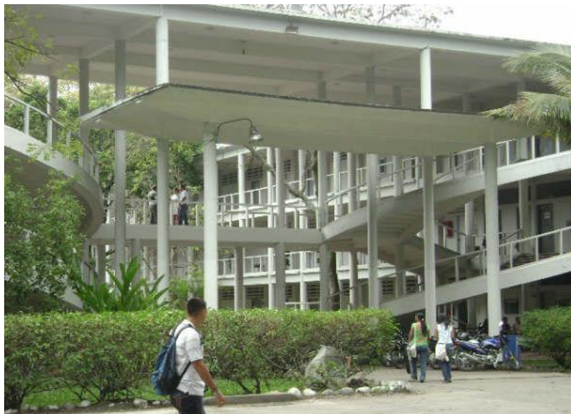
Abb. 322 Dank des Gebrauchs der Stahlbetonstruktur war es möglich, die schlanken Pfeiler und den breiten Portikus zu bauen. Foto Jan. 2008
