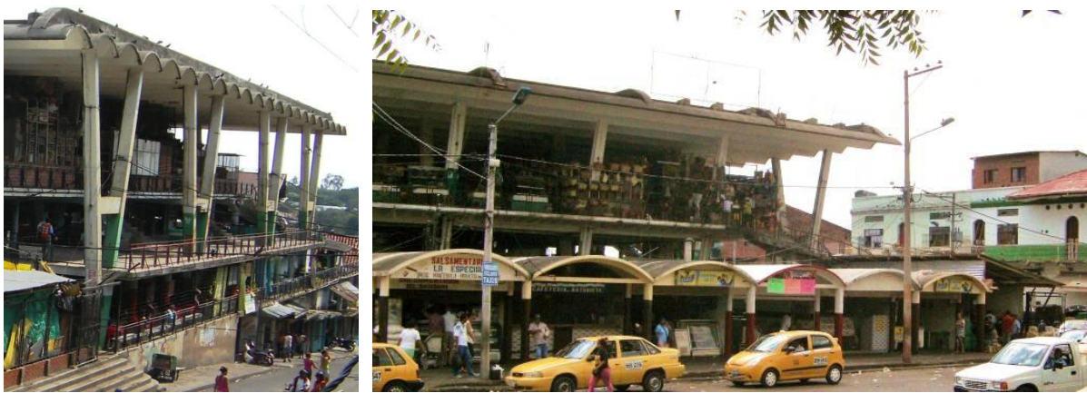
Abb. 368 Links: Seitenansicht. Abb. 369 Rechts: Hauptfassade am San Miguel Platz. Foto Jan. 2008
