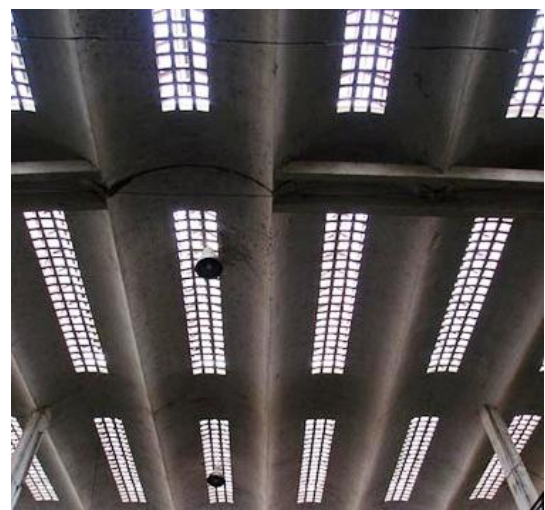
Abb. 370- 373 Die V-Stützen tragen das Obergeschoss und die Schalenüberdachungen. Foto Jan. 2008
