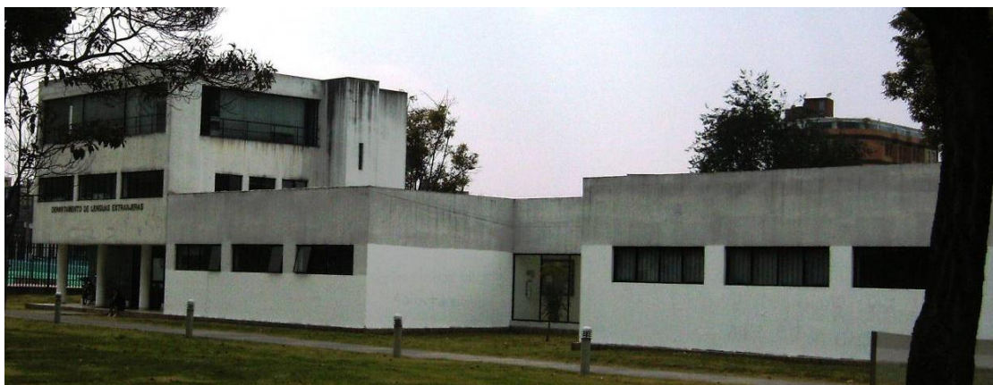
Abb. 238 Hauptfassade der Meisterhäuser im heutigen Zustand. Foto Jan. 2007
