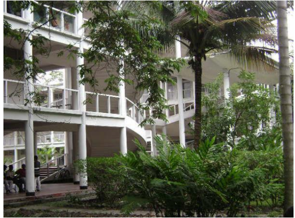
Abb. 318 Links: Offene Gänge mit tragenden Betonstützen der Unterrichtsblöcke. Abb. 319 Rechts: Blick vom Innenhof. Foto Jan. 2008
