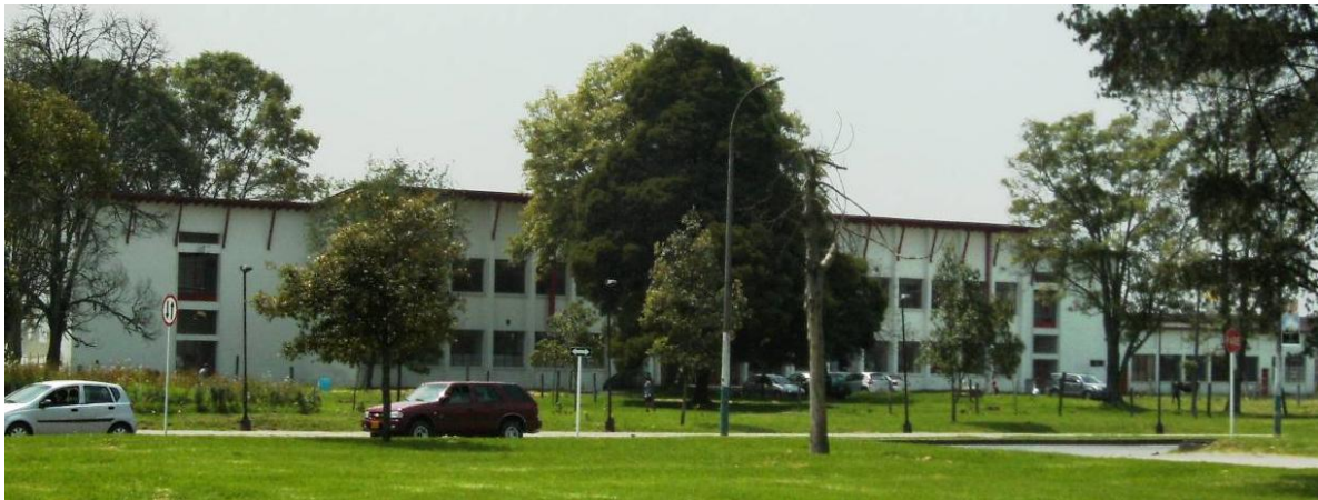
Abb. 279 Ansicht des Hauptgebäudes. Das Vordach wird von schrägen Holzpfosten unterstützt. Foto Jan. 2007
