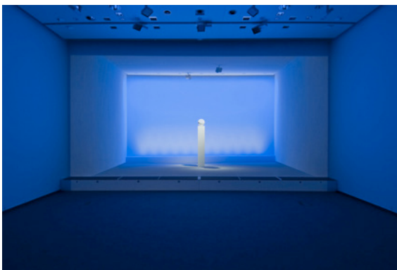
L5 Akzentbeleuchtung, Wandflutung blau und Streiflicht
