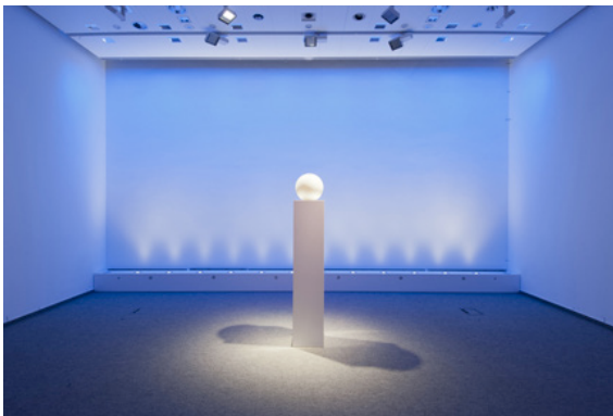
L5 Akzentbeleuchtung, Wandflutung blau und Streiflicht
