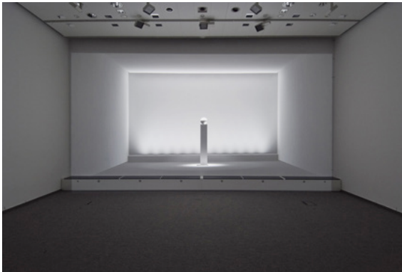
L3 Akzentbeleuchtung und Streiflicht
